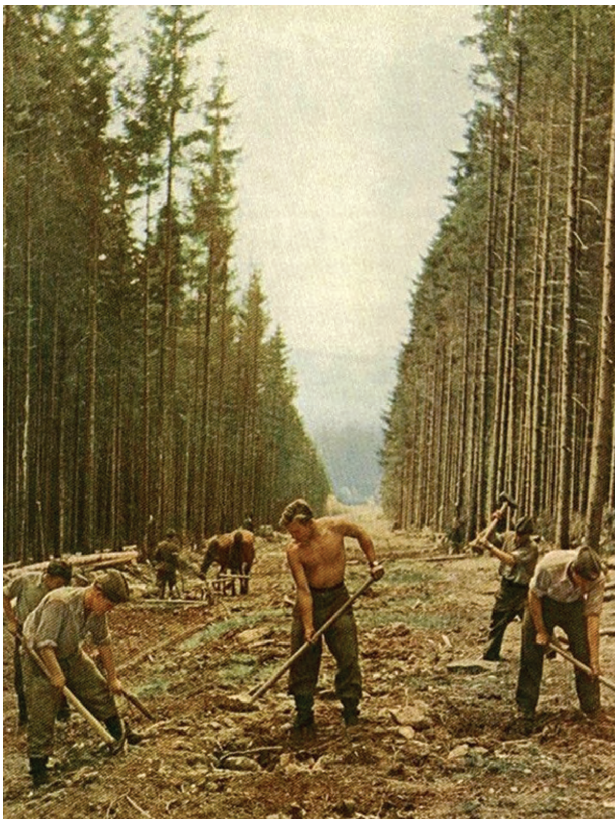
Obrázek 60 Kácení průseků pro výstavbu elektrifikovaného drátěného zátarasu
