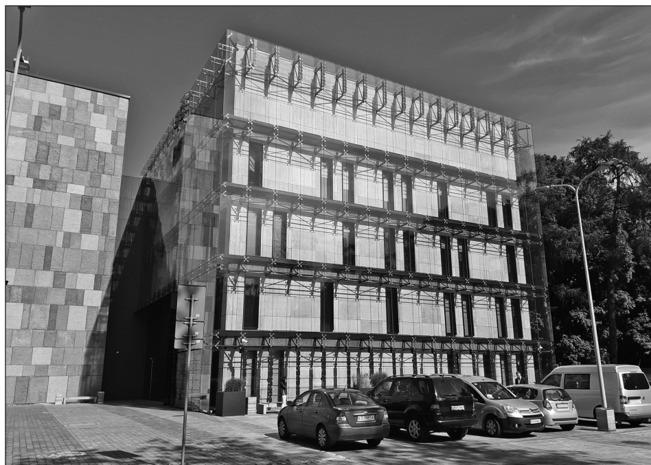
Pohled na kancelářský blok archivu
