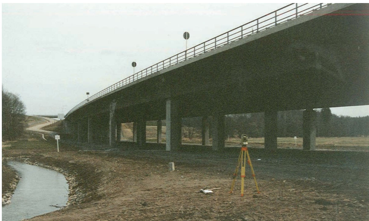
Vyměřovací práce v prostoru dálničního hraničního mostu Rozvadov-Waidhaus (geodetická příprava změnové smlouvy)
