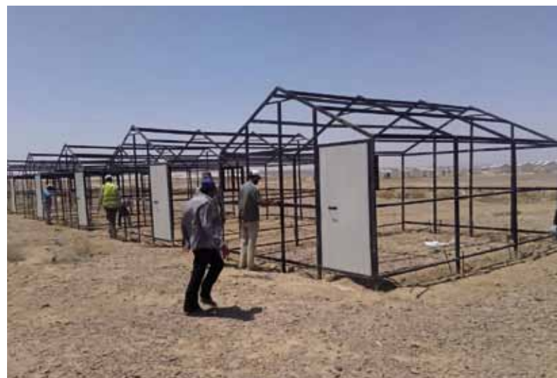
Stavba nových ubytovacích jednotek. Konstrukce byla započata sestavením skeletonu a následovalo vnější obložení, vnitřní opláštění, izolace, a podlahové práce. Na stavebních pracích se podíleli i místní obyvatelé tábora. © MV ČR, foto: Jiří Pasz
