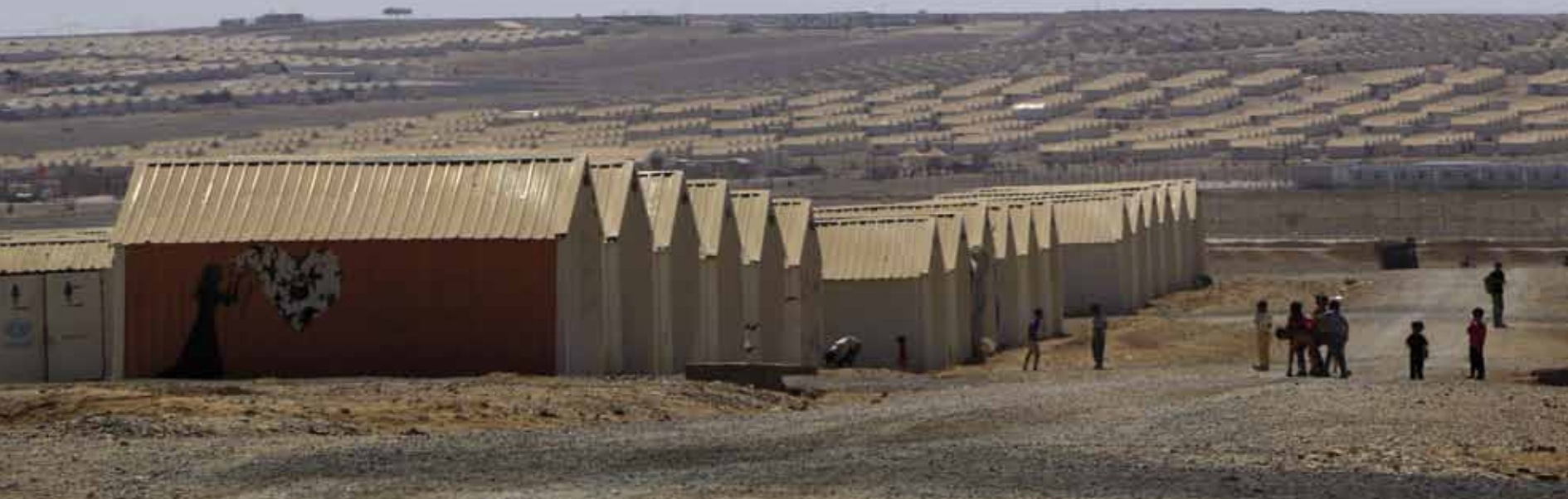
Přístřeší po renovaci. Tábor nyní tvoří celkem 10 500 obydlí a počet registrovaných stálých obyvatel činí přes 31 000. © MV ČR, foto: Jiří Pasz
